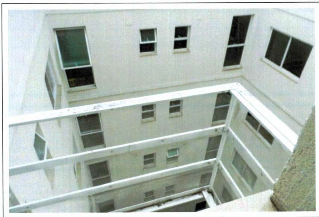
Foto 31 - Prisma de ventilação e iluminação central.
