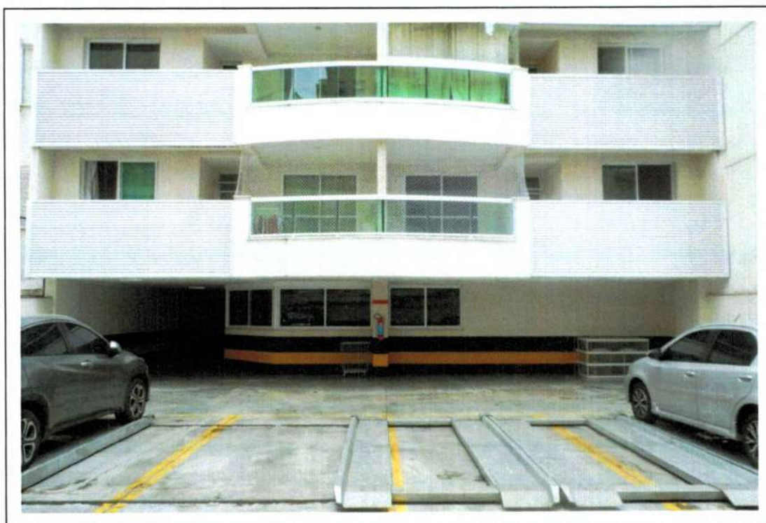
Foto 15 - Fundos da construção.
