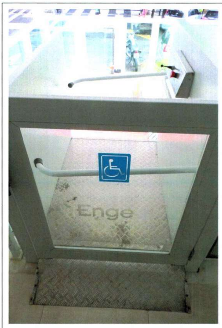
Foto 07 - Elevador para pessoas portadoras de necessidades especiais, indicando boas condições de acessibilidade.
