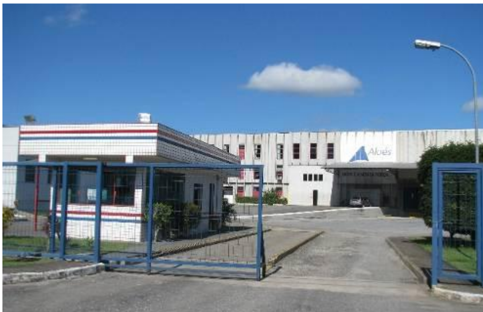
Aspecto geral frontal da propriedade.
