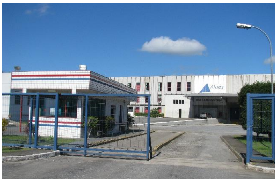
Aspecto geral frontal da propriedade.
